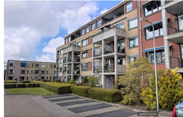
Woningbouw aan oostzijde van de locatie - Kruisbroekweg
